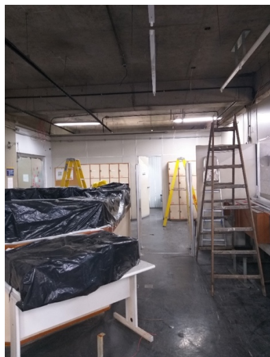
Biblioteca Comunitária: retirada do forro do teto da biblioteca
