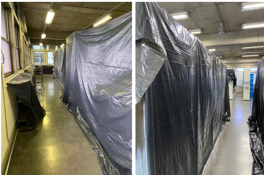
Medidas de proteção ao acervo durante as obras de recuperação das fachadas e varandas do Bloco C – campus Maracanã (jan/fev 2020)
