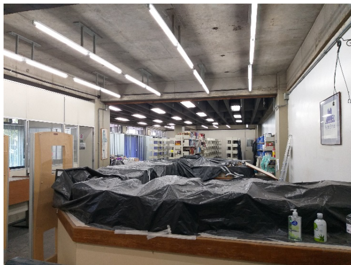
Modernização da iluminação da Biblioteca Comunitária: adequação da iluminação concluída
