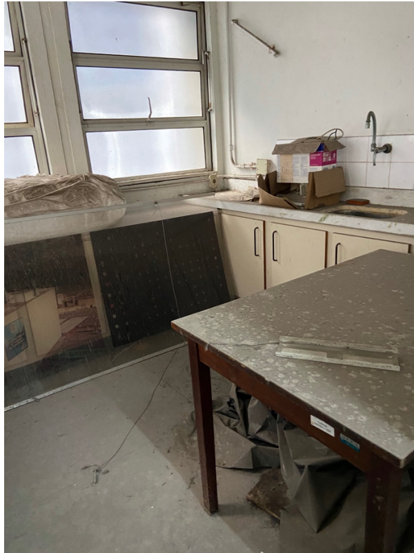
Obras das copas do Bloco C – campus Maracanã
