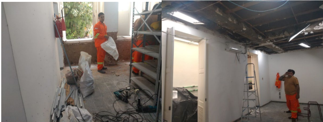
Registro das obras de revitalização da Biblioteca CCS/D-IESP
